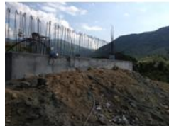
Vaciado de acero Viga cabezal
