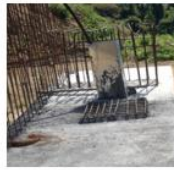
Acero y vaciado talones de apoyo
