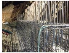
Armado de acero Viga Cabezal
