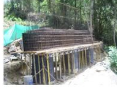
* Obra falsa estribo
