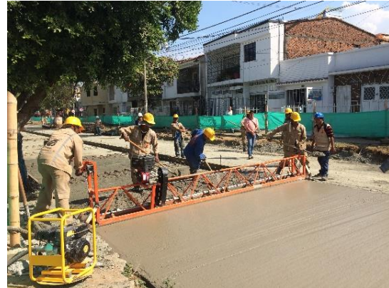
Extendido del concreto con regla vibratoria
