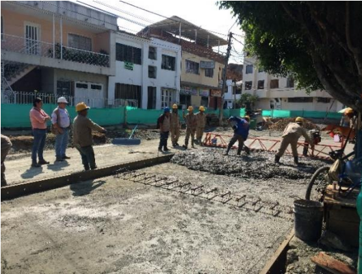
Extendido del concreto con regla vibratoria
