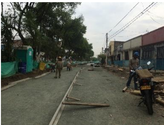
Instalación de Formaleta
