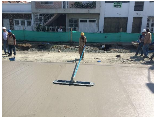
Flotado del Concreto
