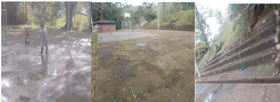
CENTRO INTEGRAL LAS GRANJAS SANCRISTOBAL: Hidrolavado de cancha
